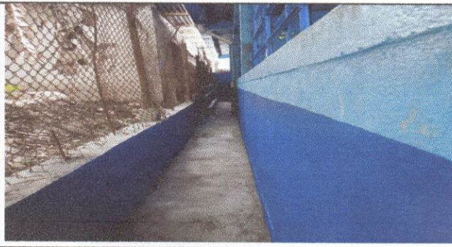
Foto 5: Se construyo cuneta de concreto.
