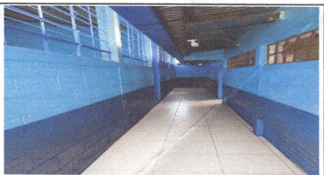
Foto 6: Pintura en muros interiores y exteriores del modulo II.
